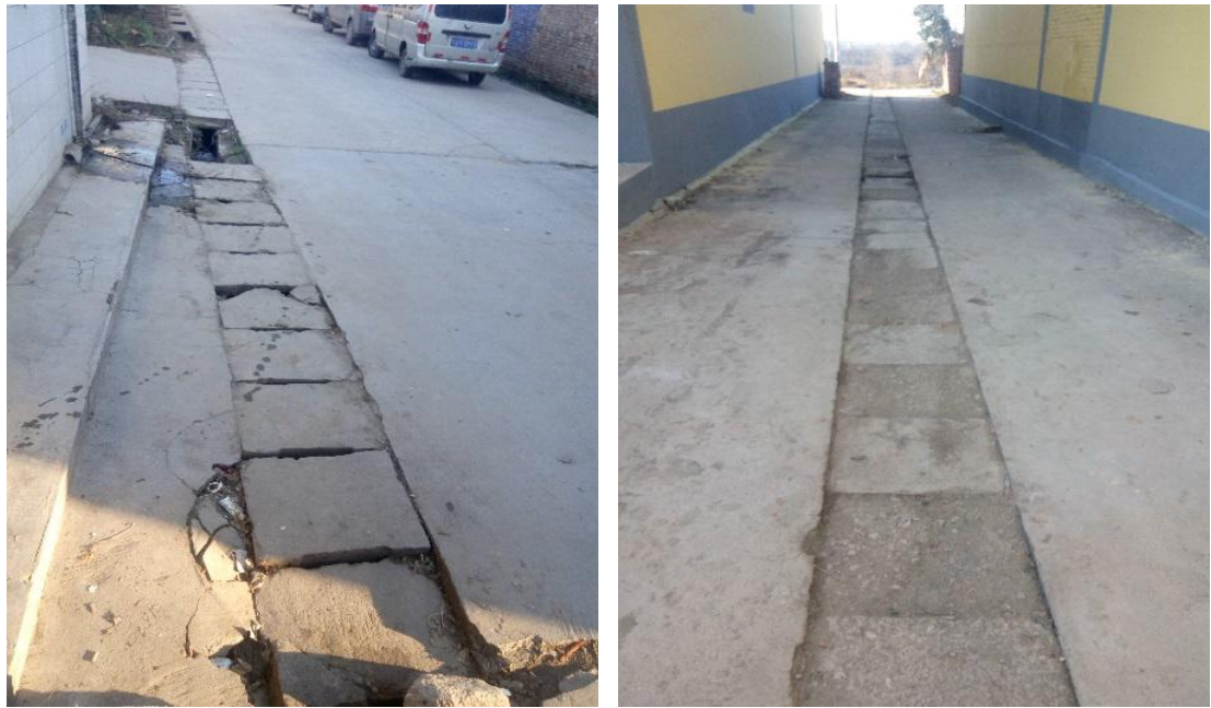
图 11.6 污水排入有盖板暗渠现状图
